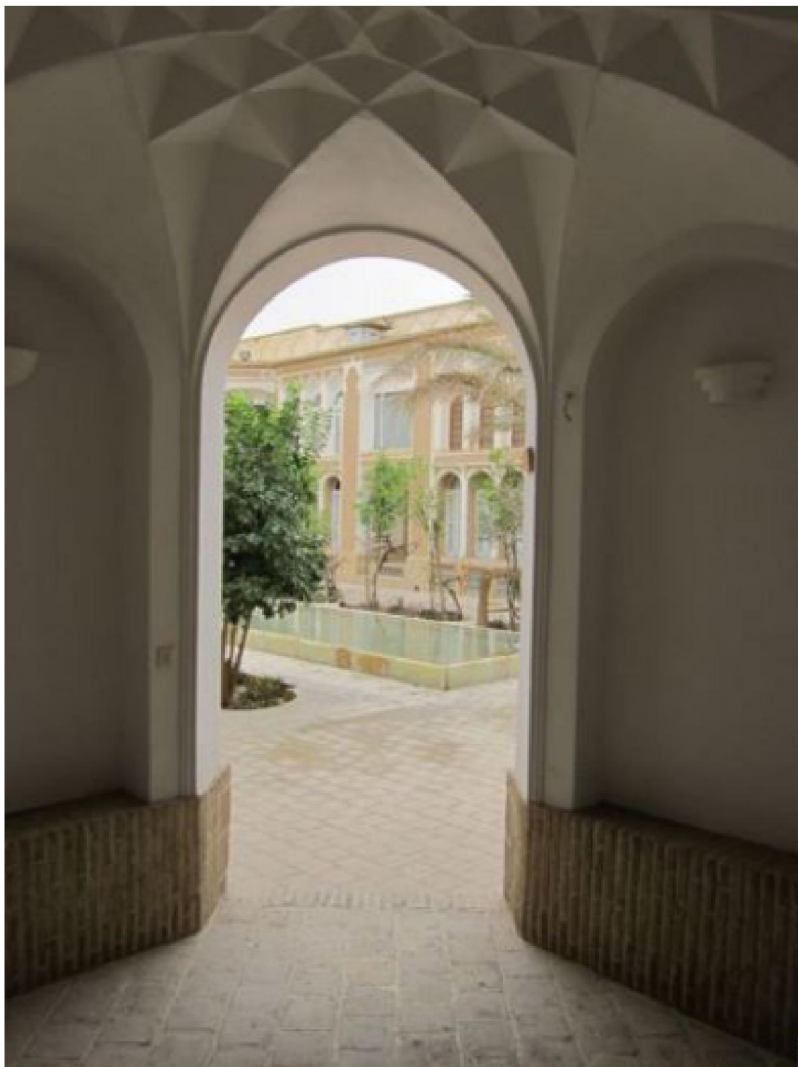
تصویر شماره ۷: نهی اشرافیت با استفاده از مسدود کردن دید مستقیم از بیرون به داخل بنا (خانه مرتاض)؛
