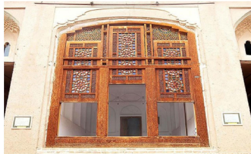
تصویر شماره ۴: استفاده از گره چینی در ساخت اوریسی به عنوان یک نمونه تزیینات کاربردی (خانه لاری‌ها)
